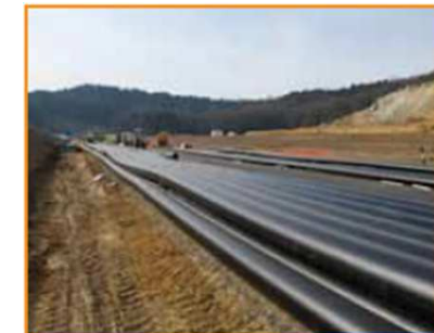
54m配管をトンネルへ
